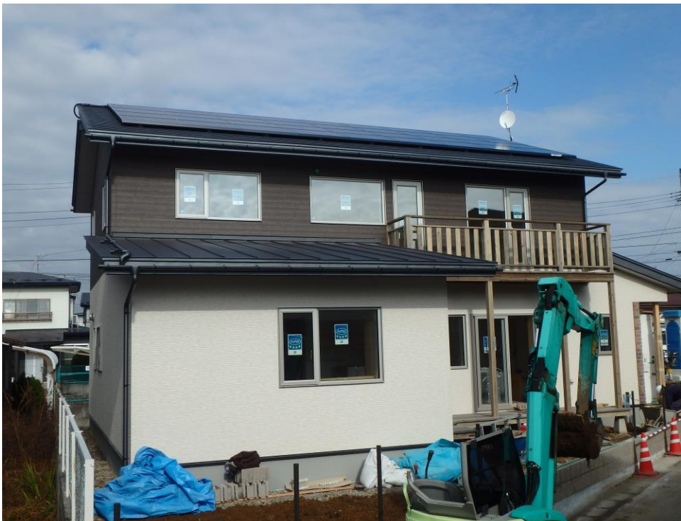
内にも外にも 105mm の断熱材。 合計 210mm 断熱。
