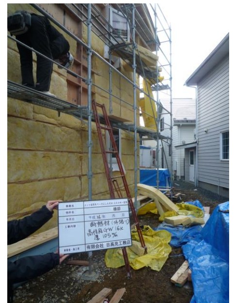
内にも外にも 105mm の断熱材。 合計 210mm 断熱。
