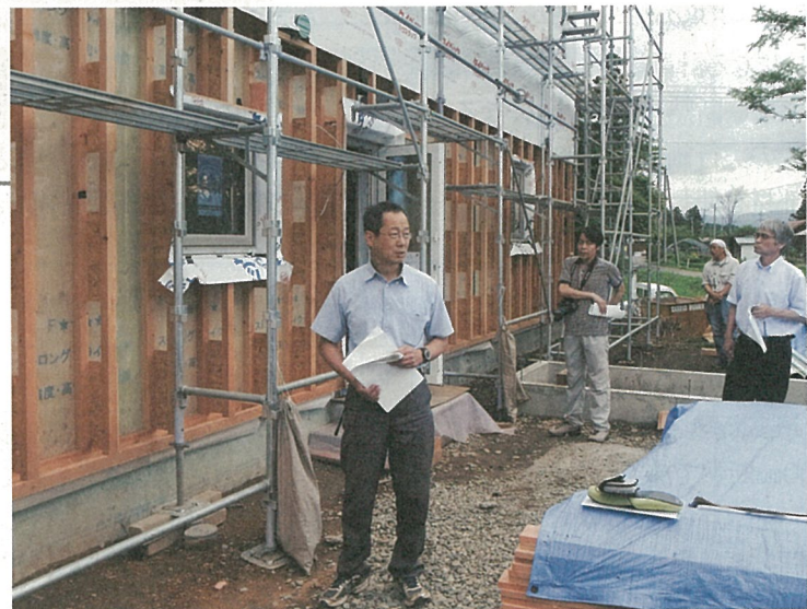
地元の工務店団体の合同研修で付加断熱部分を説明する千田社長(写真中央)
