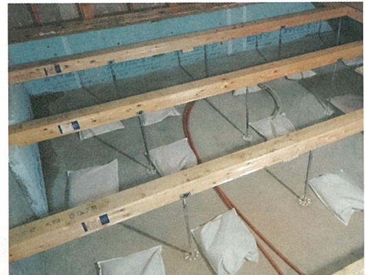
床下に置き敷きされた袋入りの稚内産珪藻土
