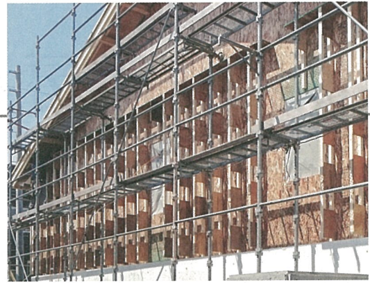
付加断熱下地となる200mm幅の“はしご状”パネルを455mmピッチで施工
