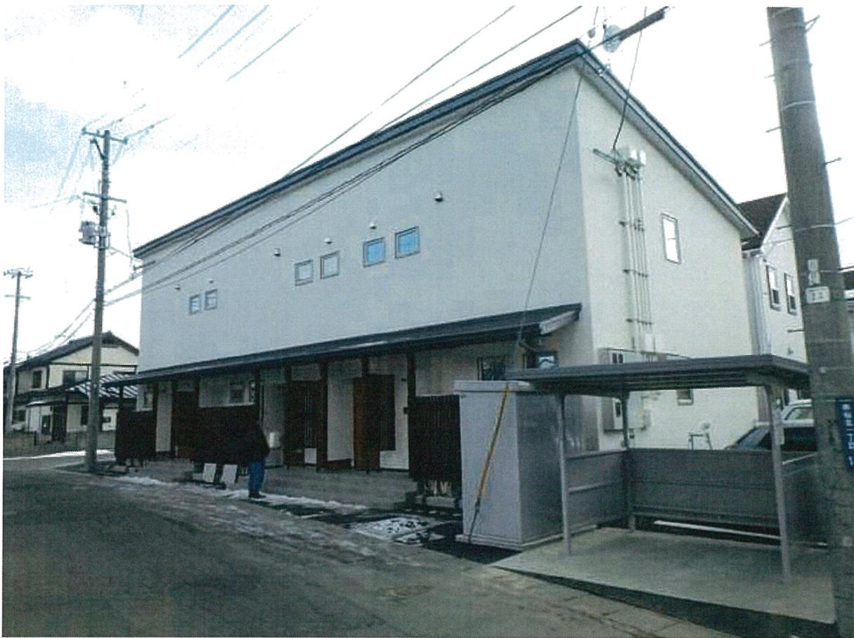
建物は長屋タイプの1LDK全6戸。1戸の専有面積が1階37.12m<sup>2</sup>、2階48.99m<sup>2</sup>。外皮断熱性能UA値は0.12~0.17（写真：日高見工務店）
