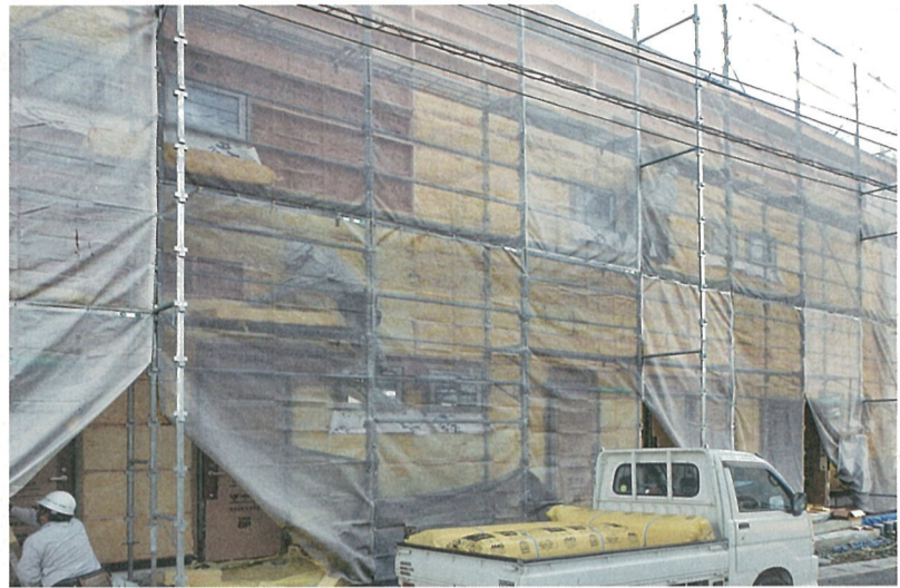
付加断熱材の高性能グラスウール105mmは、構造用合板の上に横使いで取り付けられた間柱材を下地として施工した
